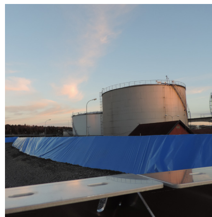
La barrière H150 vue du côté où l'eau sera retenue.
