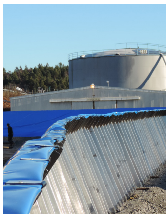
La membrane double est fixée avec les clips. Après l'écrêtage rabattez le bord et fixez le membrane au sol.
